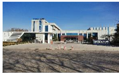
电力自动化产业园
