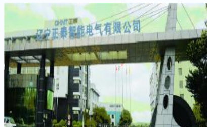
正泰东北产业园
