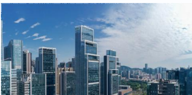
建筑行业解决方案 温州华润万象天地项目
