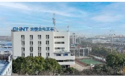
合电正泰（合肥）基地
