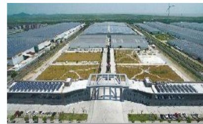
正泰新能嘉兴基地
