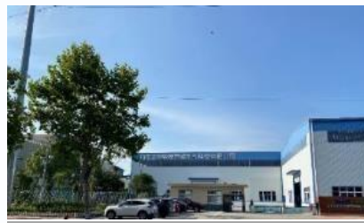
河南正泰基地
