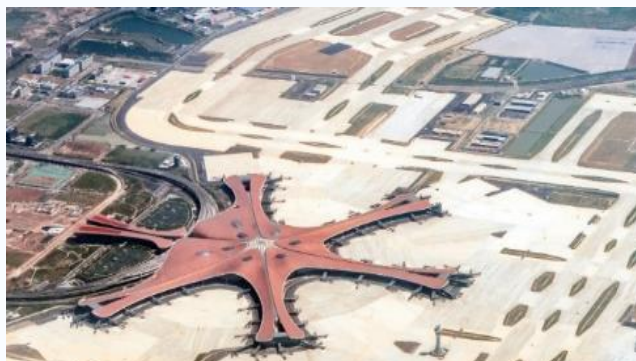
基建行业解决方案 北京大兴机场输配电项目
