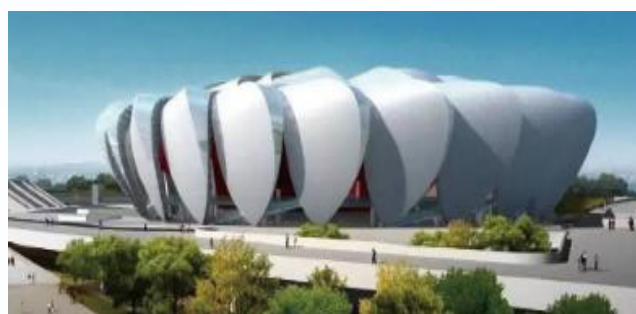
工装行业解决方案 杭州亚运会场馆项目
