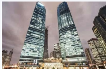
上海国际金融中心 (开关柜)
