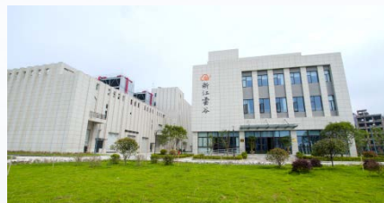
浙江乐清磐石云谷数据中心 (开关柜)
