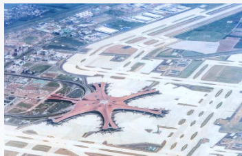
大兴机场 (箱变、开关柜)
