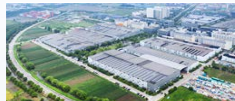
高压输变电基地 (上海松江)
