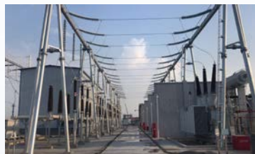
内蒙古通威220kV变电站EPC 总承包工程-EPC+O
