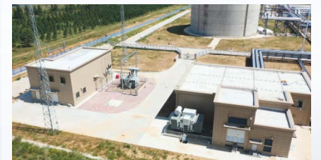
乌兰察布兴洁110kV变电站项目 (泰无忧智慧电力运维)
