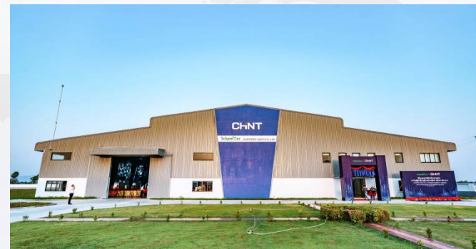
中低压集成配电及10kV及以下配电变压器制造基地 (柬埔寨普萨)
